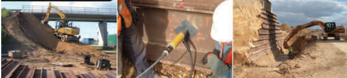
укрепление шпунтовых стенок
