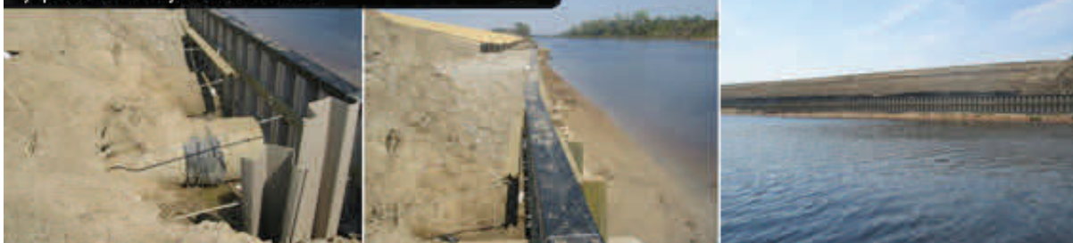
укрепление шпунтовых стенок
